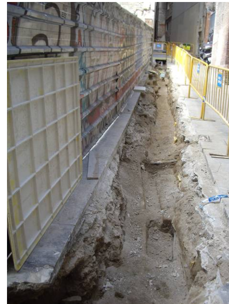
4. Excavació de la rasa del carrer Baixada Caçador
