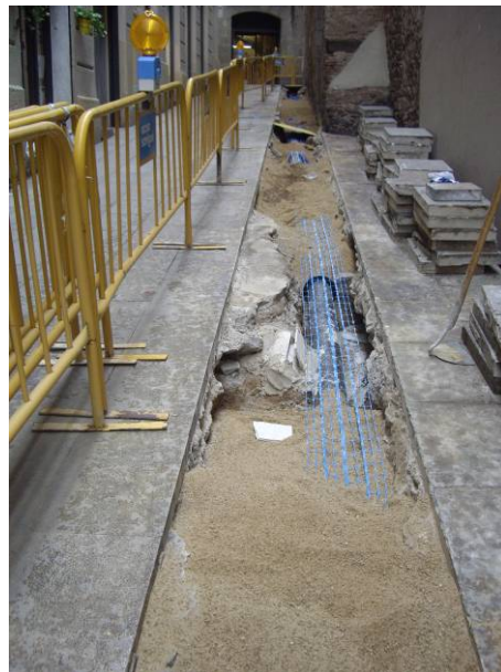
8. Cobriment de la rasa, tram 1
