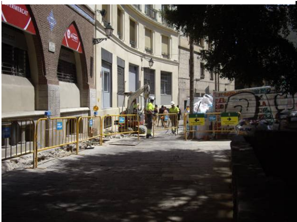
19. Picant el formigó del creuament entre el tram 1 i 2
