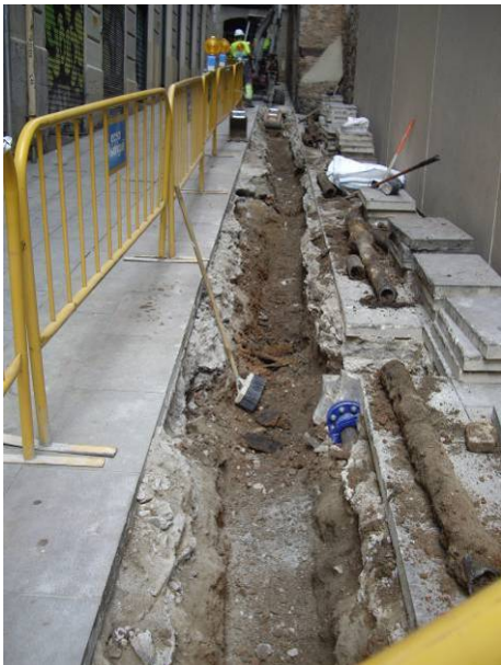
3. Excavació de la rasa del carrer Baixada Caçador
