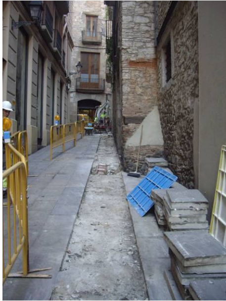
1. Retirada del paviment del carrer Baixada Caçador (tram 1), vista oest
