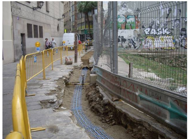
16. Cobriment de la rasa al tram 2
