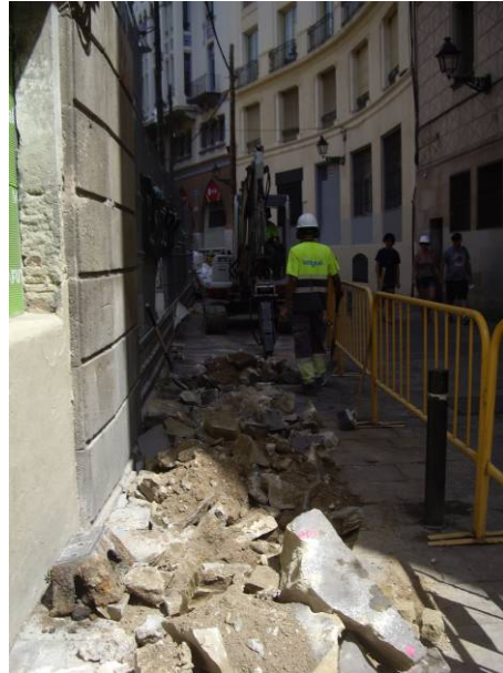
10. Obertura de la rasa tram 2, carrer Sotstinent Navarro, sentit nord
