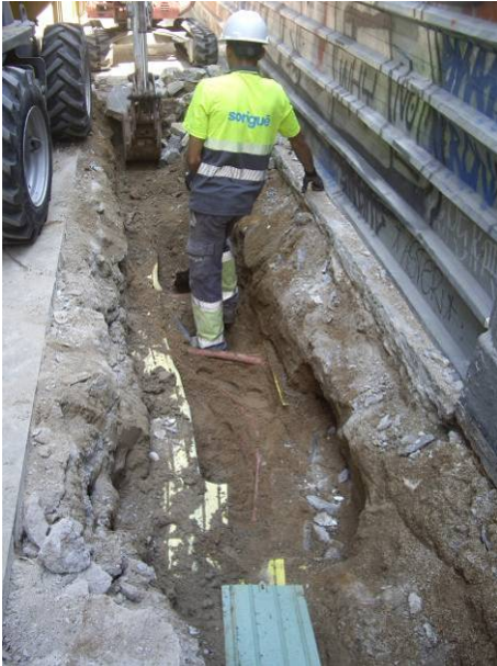
9. Obertura de la rasa tram 1, sentit est
