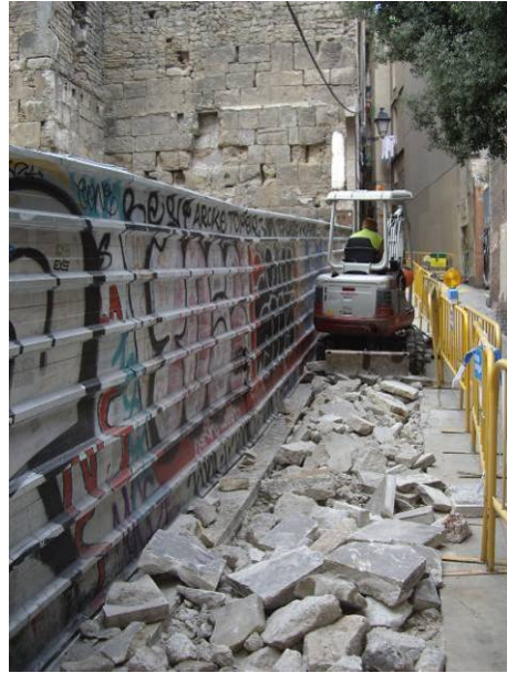
2. Retirada del paviment del carrer Baixada Caçador (tram 1), vista oest
