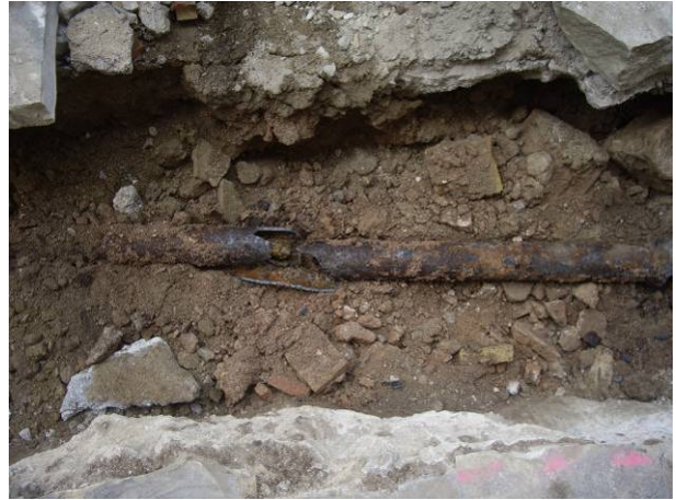
14. Tram 2, tub antic d'aigua que es substitueix per la nova canonada
