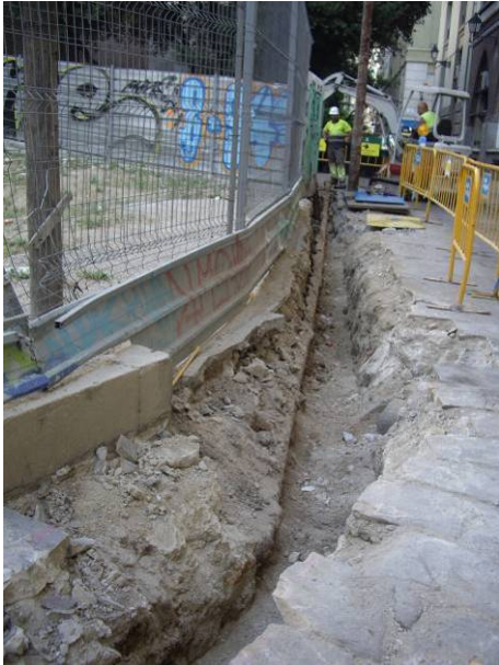
13. Rasa oberta tram 2 davant núm,14-16
