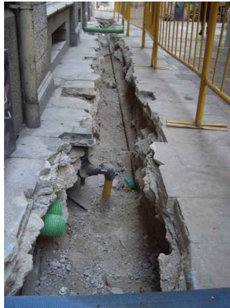
22. Rasa oberta tram 2, vista sud del carrer
